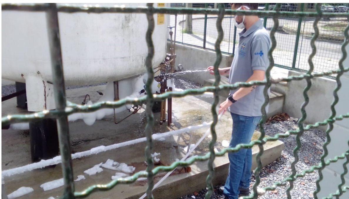
Descongelamento do tanque de oxigênio
